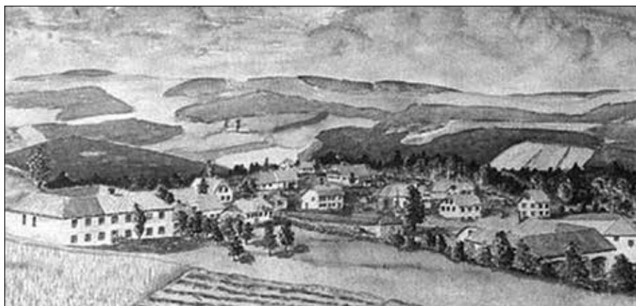
Foto z kapličky na Pošláku
