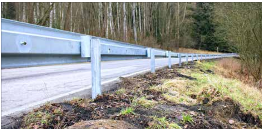
Nová svodidla za Vyším Brodem.
