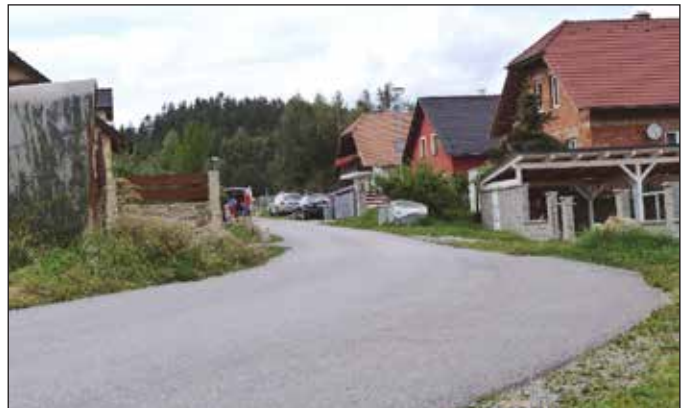
Opravená cesta na Přízeři
