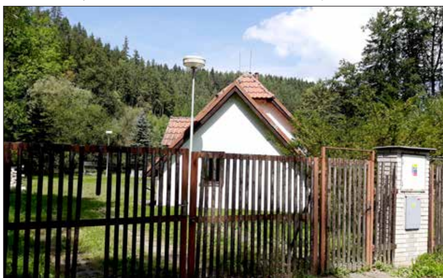
Rožmberk čeká na novou čističku odpadních vod
