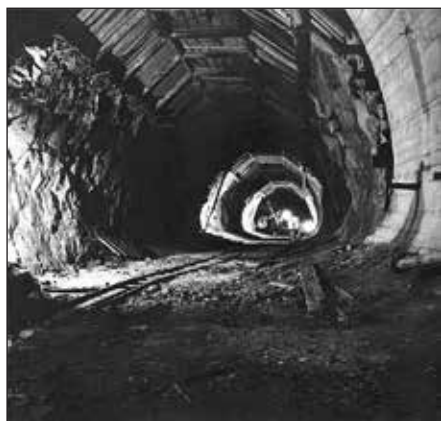
Ražba odpadního tunelu.
